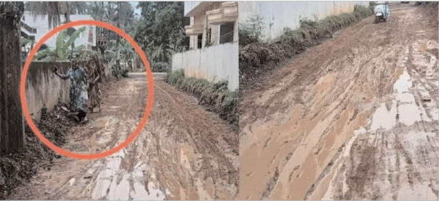
వెళ్ళేవారు అయితే జరుగుతూ ఉన్న పనులన్నీ ఆసుపత్రిలో వైద్యాధికారిగా పనిచేస్తున్న డాక్టర్ కూడా శనివారం ఇదే చేదు అనుభవాన్ని ఎదుర్కొన్నారు. పడేళ్ళ క్రితం నిర్మించిన రోడ్డు దిక్కు..
