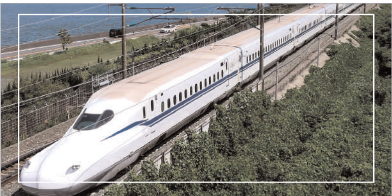
ఇందులో 310 కిలోమీటర్ల మయాడక్ట్స్ నిర్మాణం పూర్తయింది. బుల్లెట్ ట్రైన్ ప్రాజెక్టులో
